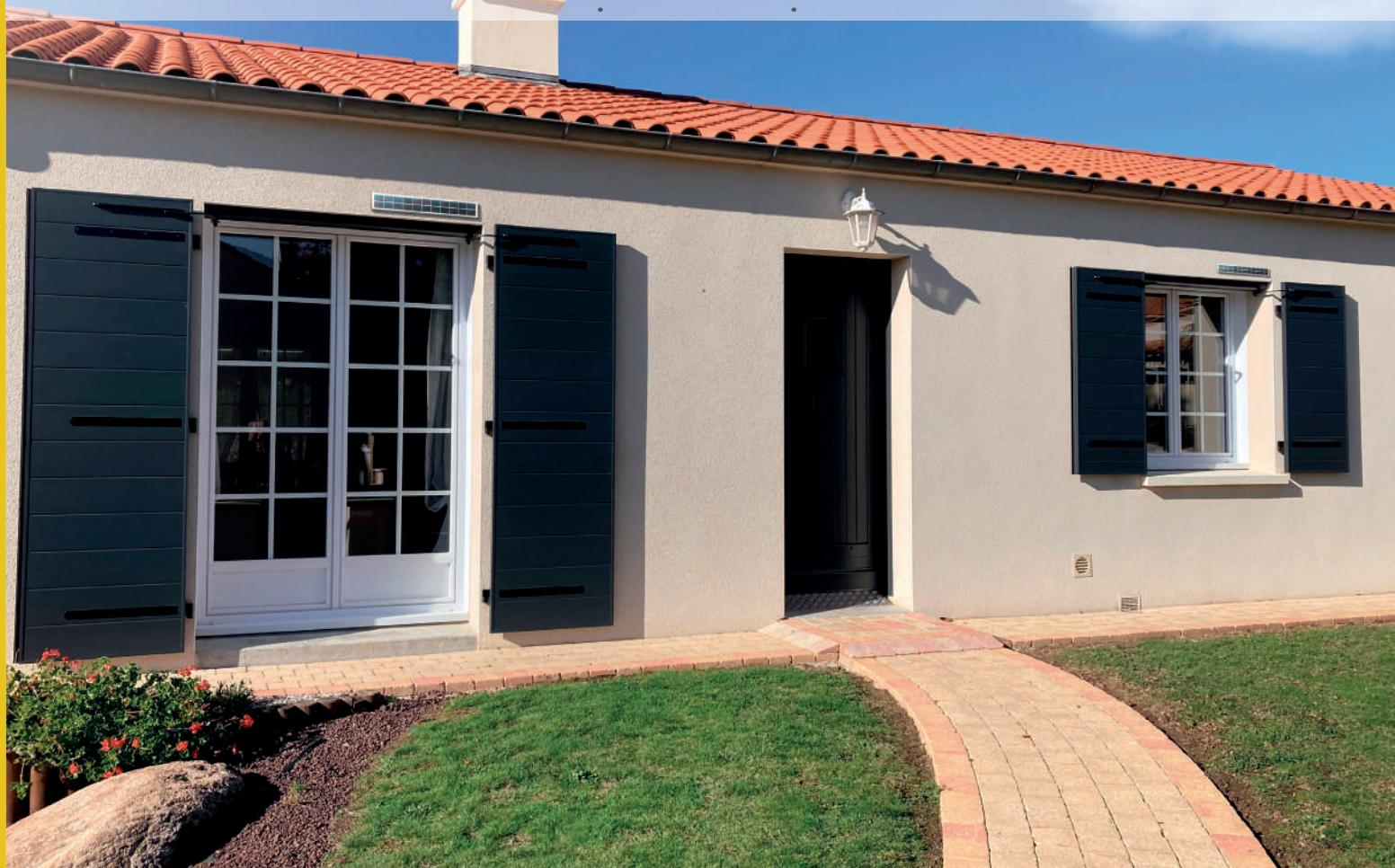
Mistral battants solaires - RAL 7016 - Lames verticales 170 mm avec pentures et contre pentures
