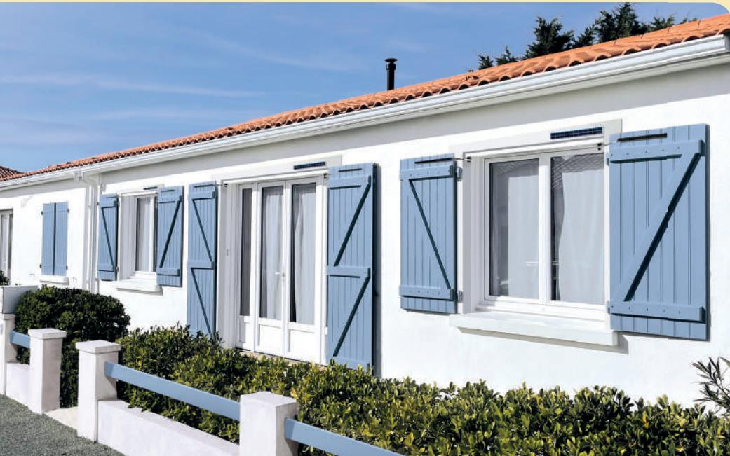
Mistral battants solaires avec bati rénovation - RAL 5014 - Lames verticales 85 mm avec barres et écharpes
